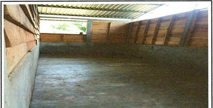
Foto 4: Sustitución de paredes de madera por deterioro
