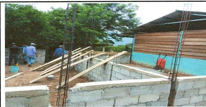
Foto 5: Área de piso que debe ser cementado
