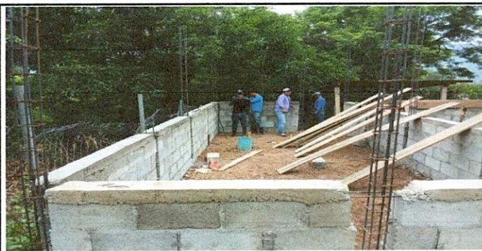
Foto 3: Sustitución de paredes de varas por deterioro
